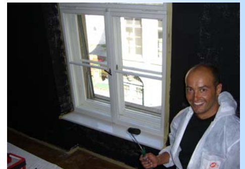
Fenster werden anschließend mit Abschirmstoffen ausgestattet
